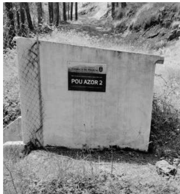
Foto de pozo existente en Vistabella del Maestrat - Castellón.
